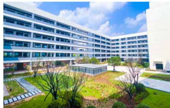
长沙市一中城南中学（初中）项目正进入最后冲刺阶段，确保顺利交付
