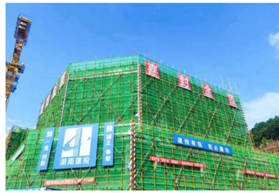
桑植县创新创业园一期建设项目完成2栋楼的混凝土浇筑，顺利进行封顶仪式
