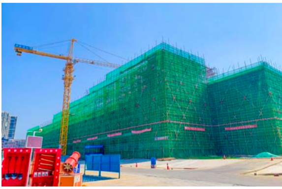
桃江县汽车站项目主体工程完成90%，室外工程完成10%
