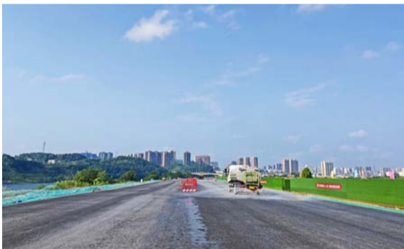
永州湘江西路（零陵北路—永州大桥段）项目已完成土路基填筑、排水工程及碎石底层、二层水稳摊铺等结构层
