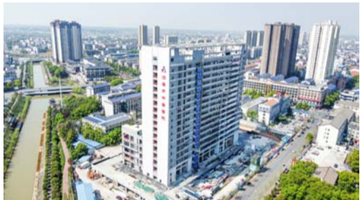
汨罗市中医医院住院综合楼建设项目主体工程已全部完工，现阶段进行室内外装修、暖通、消防、给排水等工程同步进行
