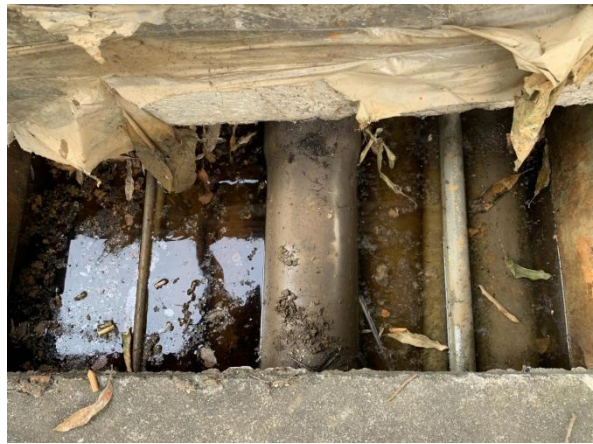
图 4.5-4 污水管道正常
