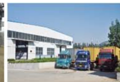
装箱平台 Container loading platform
