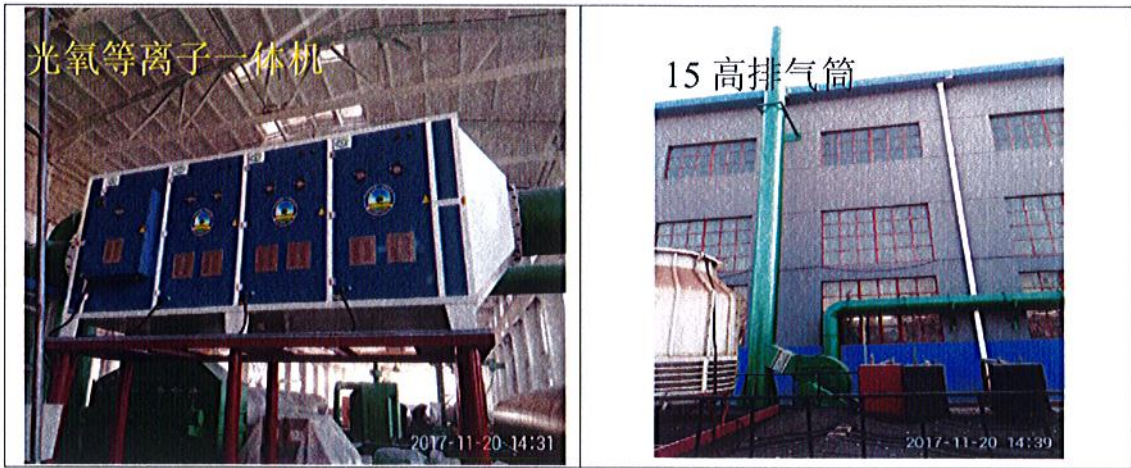
图 3-3 胶层及 PE 缠绕工序光氧等离子一体机现场照片
