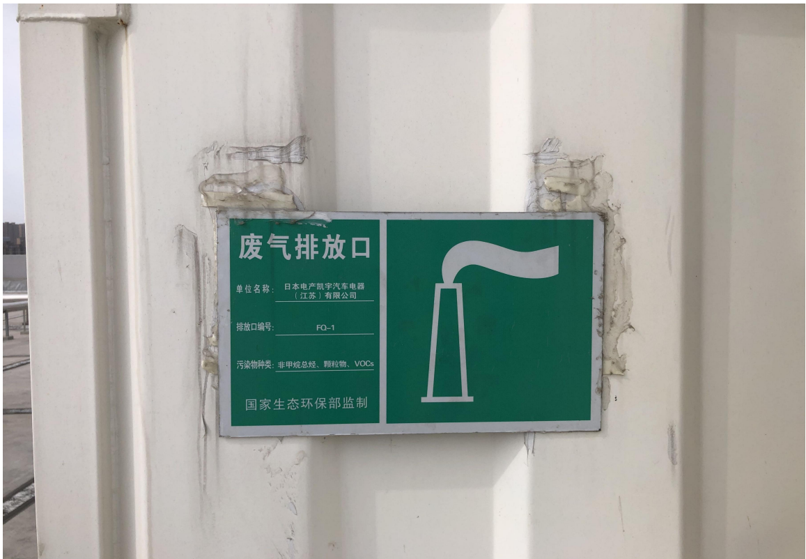
废气排气筒环保标识牌
