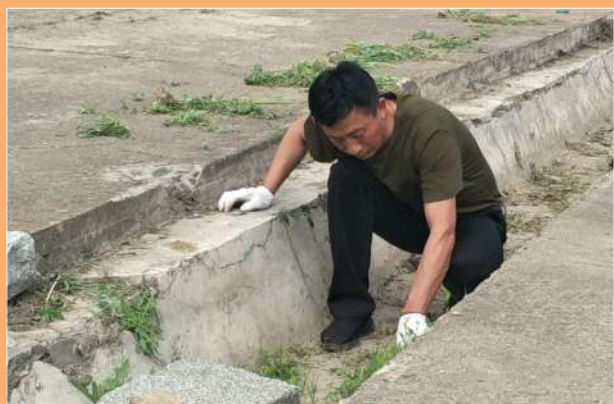
五常市拉林第五粮库主任姜波在烈日下清理排水沟杂草 以保障排水畅通
