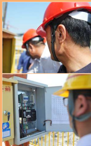
对用电设备、消防设施、应急器材等开展安全检查
