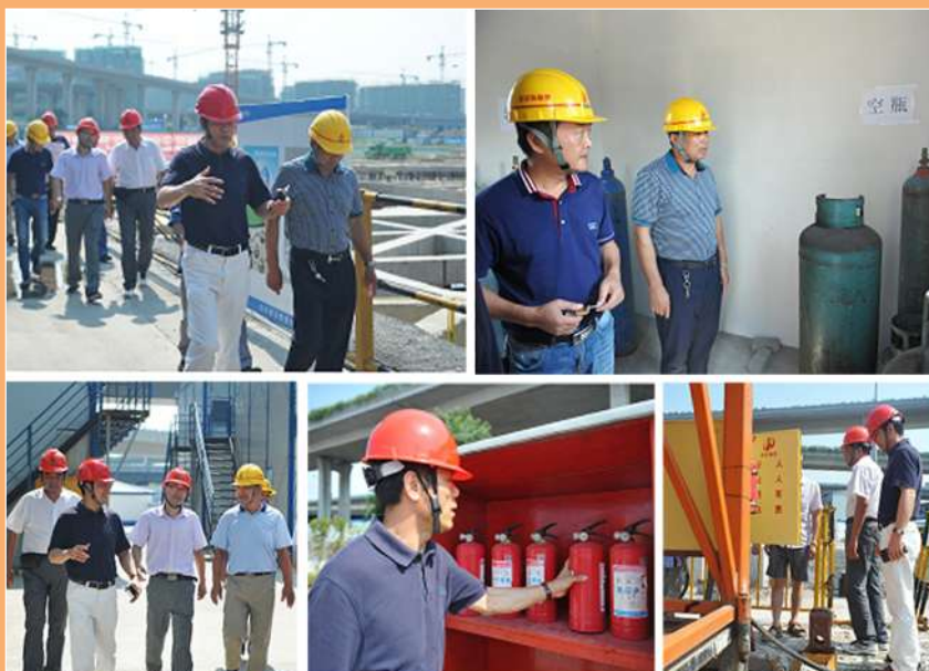
项目组增加现场巡查频次,开展技术交底及安全教育
