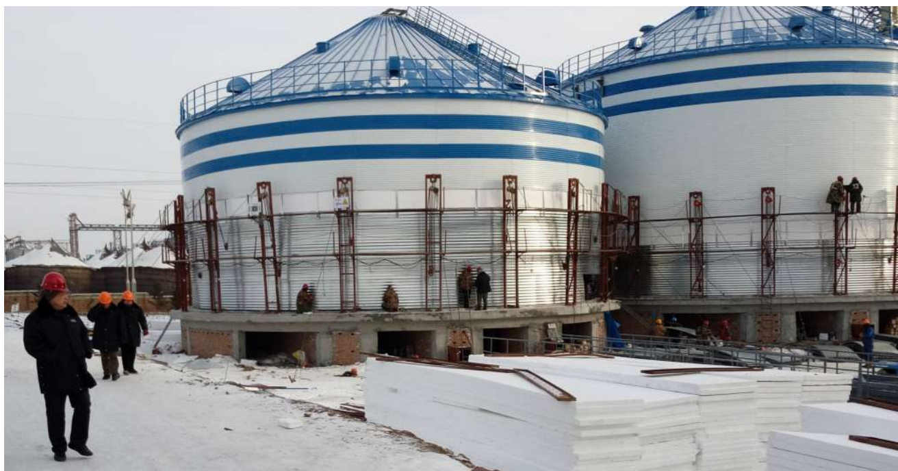
虎林迎风粮库实施库容库貌改造工程
