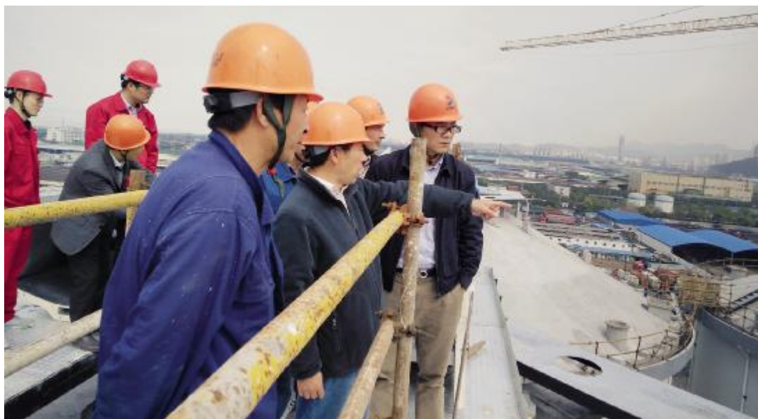
4月5日 粮食集团常务副总经理傅安民登上30多米浅圆仓顶查看工程进展。
