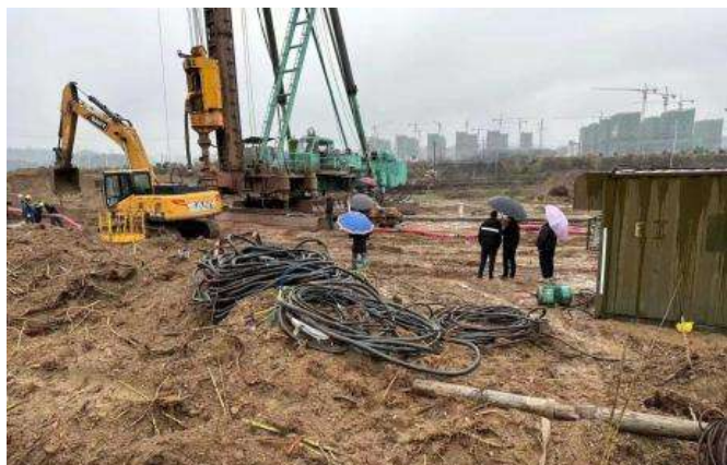
△丽水项目施工现场
