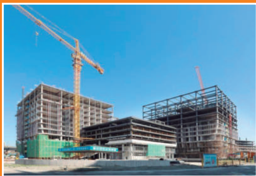
△农发·城市厨房项目施工现场
