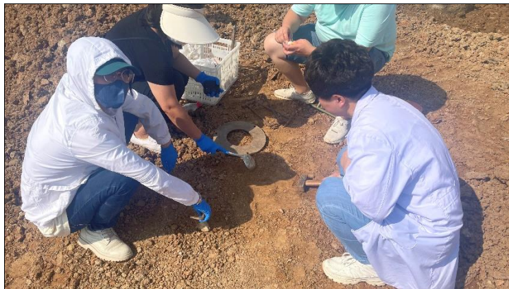
压实度试验照片
