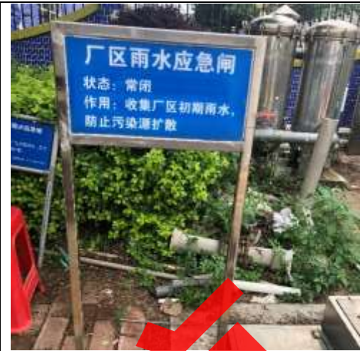
雨水应急阀门 2 标识牌
