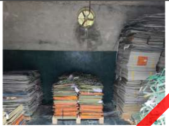
危废仓 2 的通风、防渗措施
