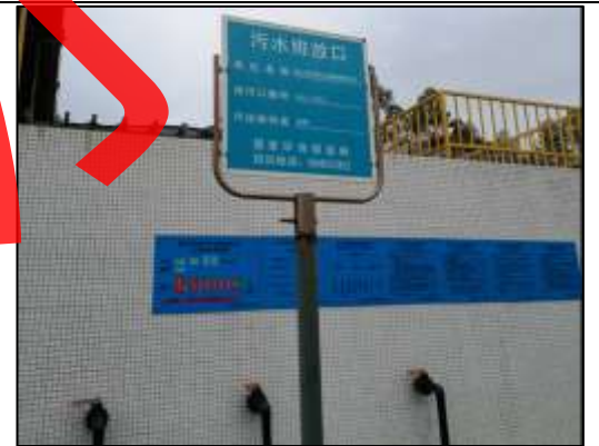
含镍废水车间排放口 2
