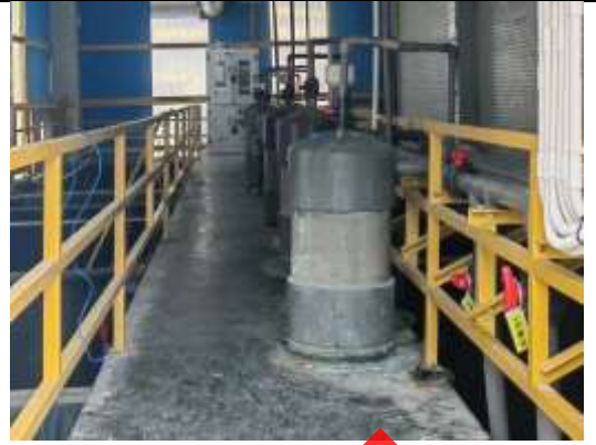
废液暂存仓地面防渗
