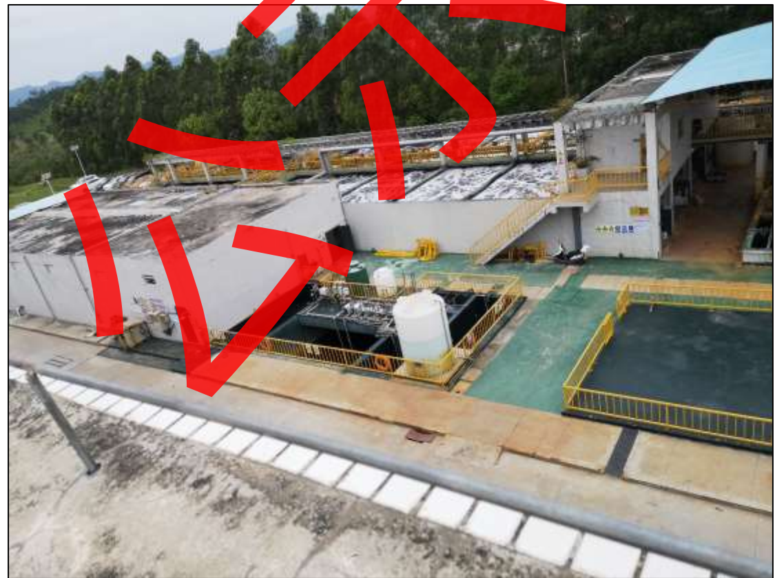
厂区废水处理站 2
