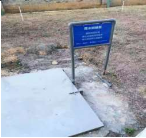
雨水排放口 1 雨水回抽泵标识
