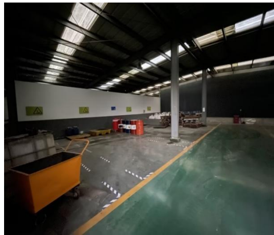
危废暂存设施内部照片
