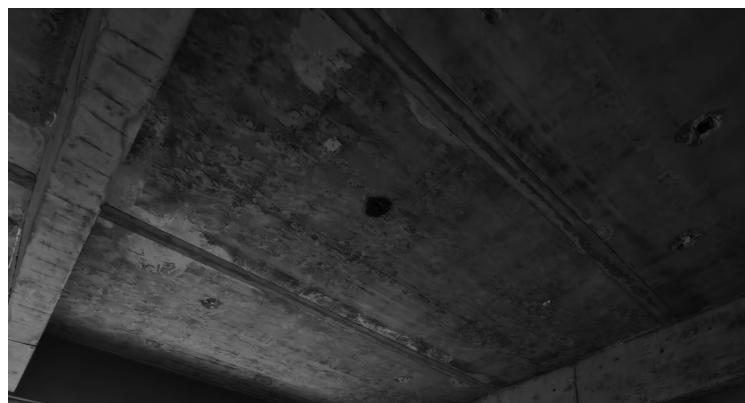
图7 现场裂缝、渗漏图
