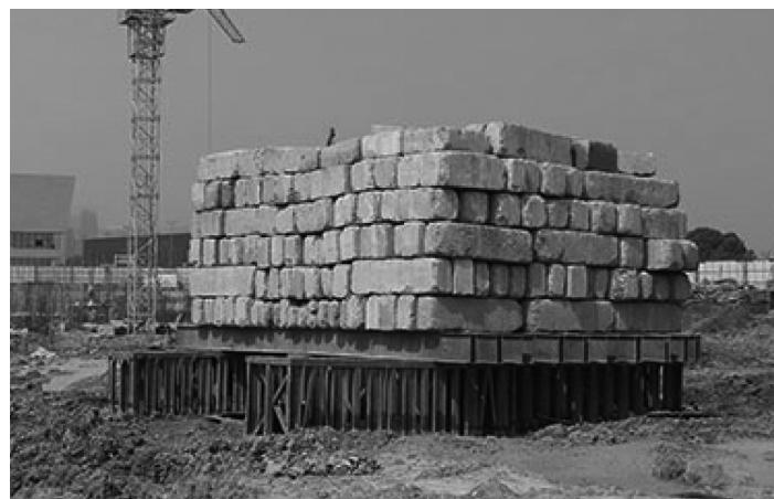
图3 桩基静荷载试验
