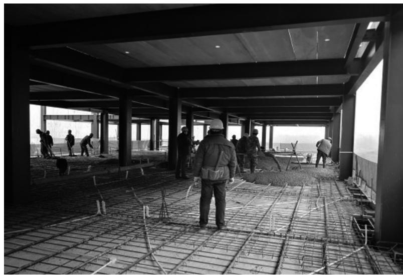
图3 底部无支撑,上下层楼面同时施工实例图
