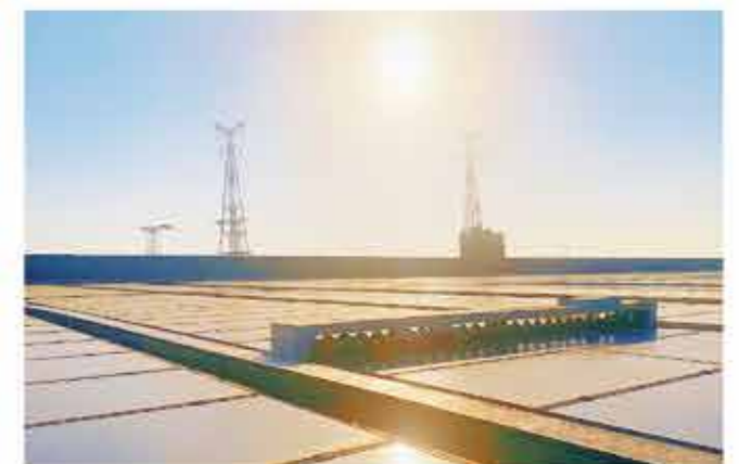
芜湖2MW光伏屋顶项目 Wuhu 2MW rooftop project
