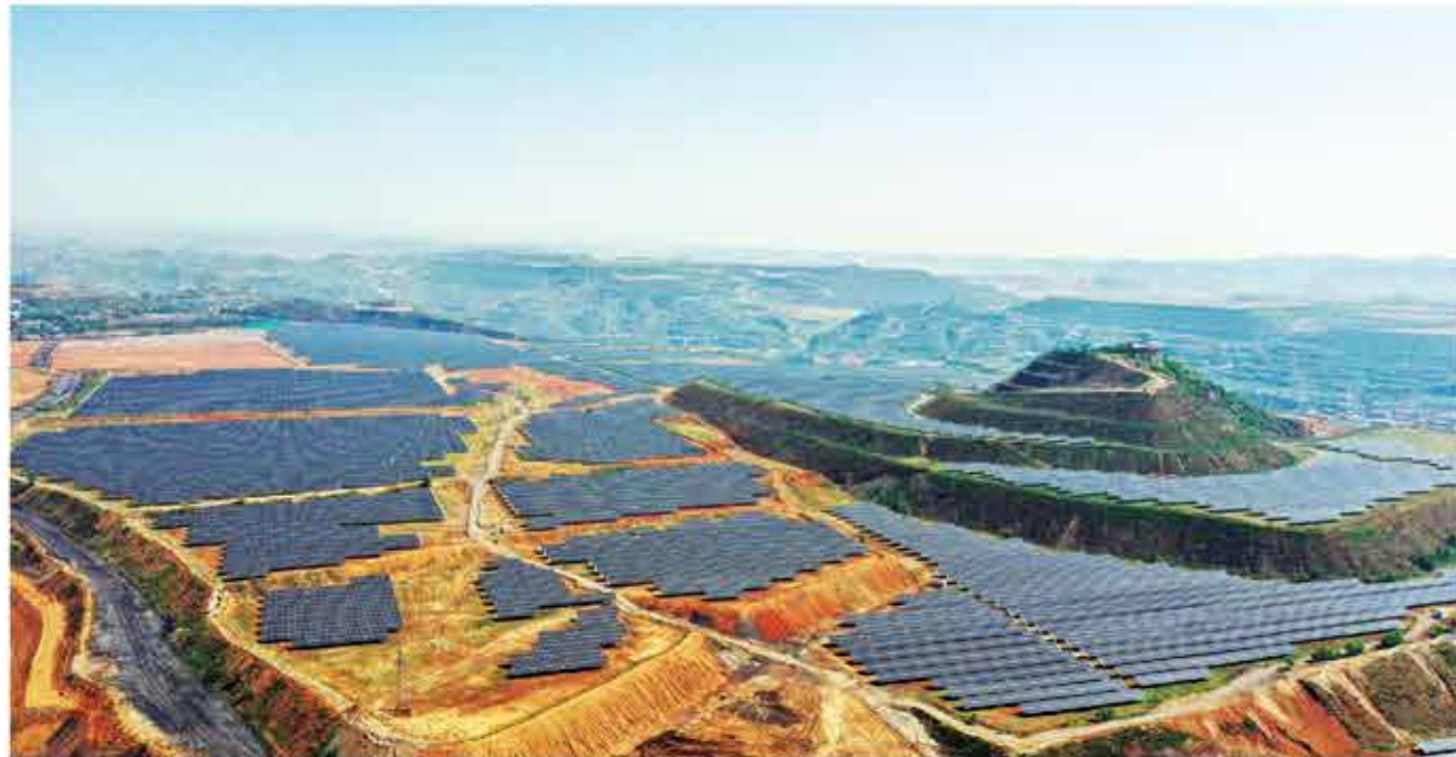
山地煤矿 Coal mining subsidence 山西交口84MW光伏发电项目 Jiaokou 84MW PV project
