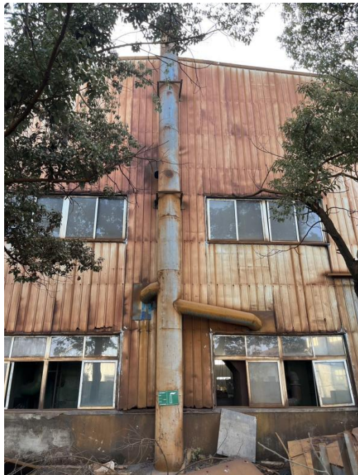
精抛废气排放口
