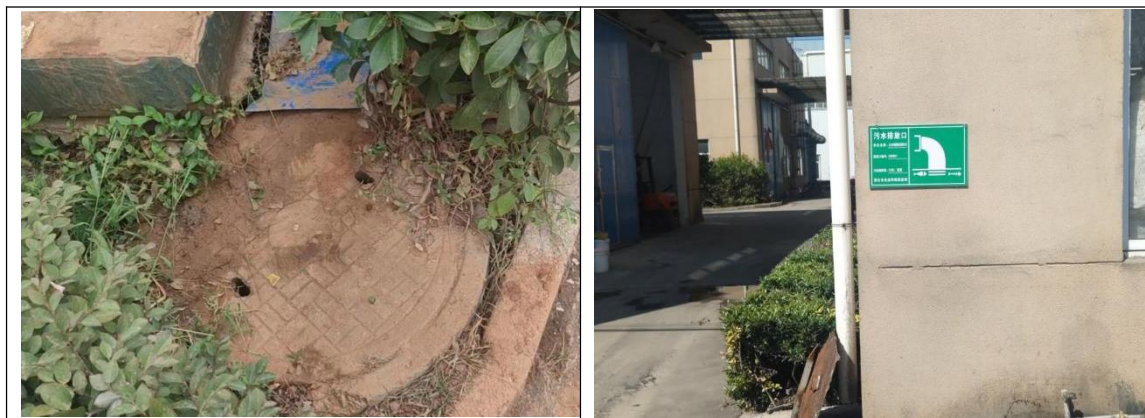
生活污水排放口
