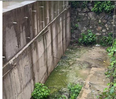
初期雨水收集池
