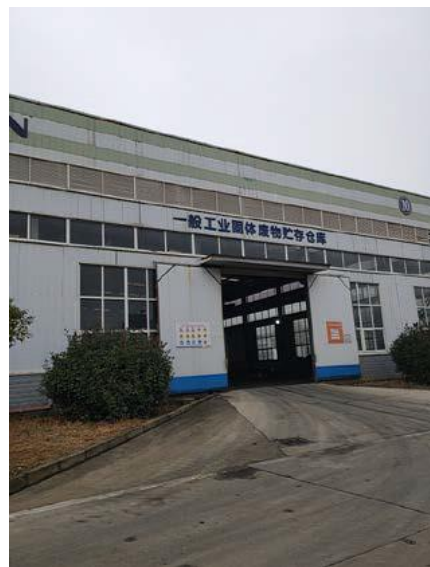
一般固废暂存间
