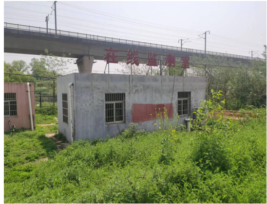
废水在线监控室外部
