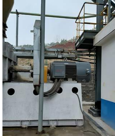
设备安装减震基础
