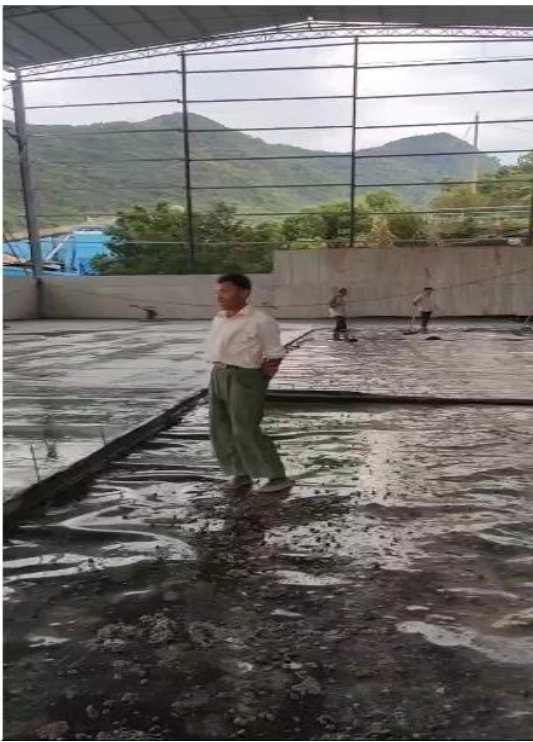
废电路板无害化处理生产线防渗照片
