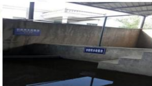
初期雨水收集池
