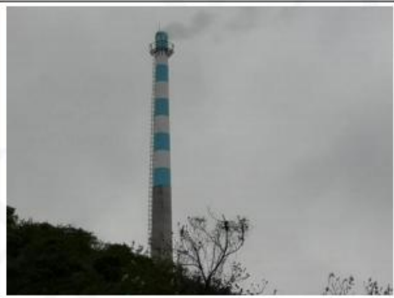
96m 烟气总排口
