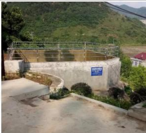
初期雨水收集池
