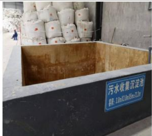
污水收集沉淀池
