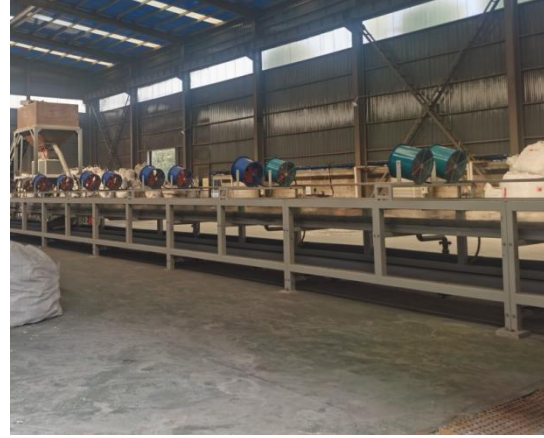
车间地面防渗
