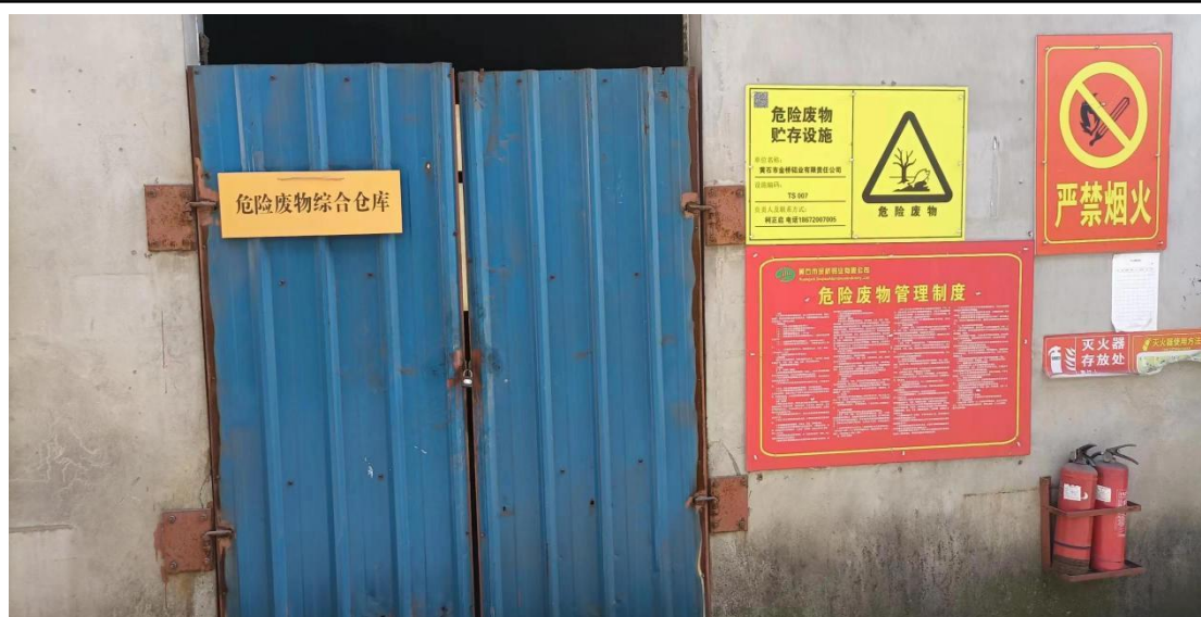
危险废物暂存间
