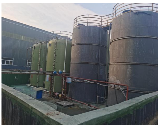
储罐区防渗及围堰
