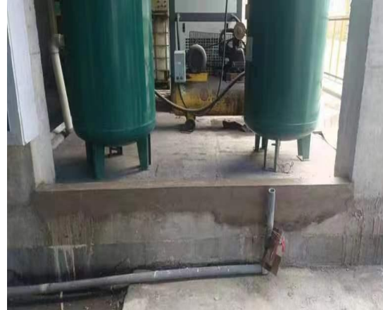
循环水池围堰
