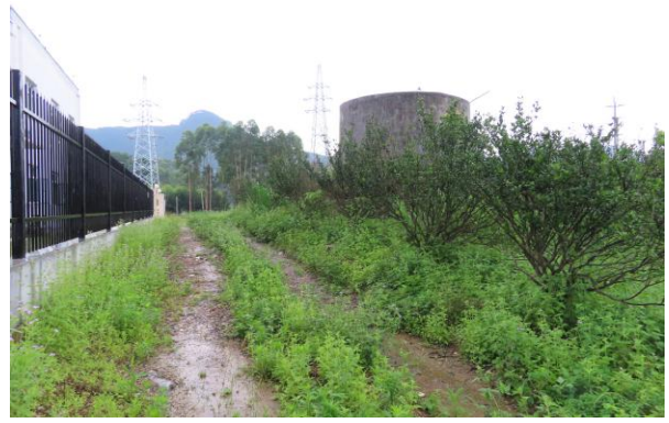
升压站站外植被恢复
