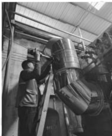
投、出料废气处理前采样口
