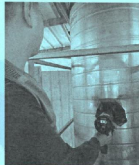
投出料废气处理后采样口
