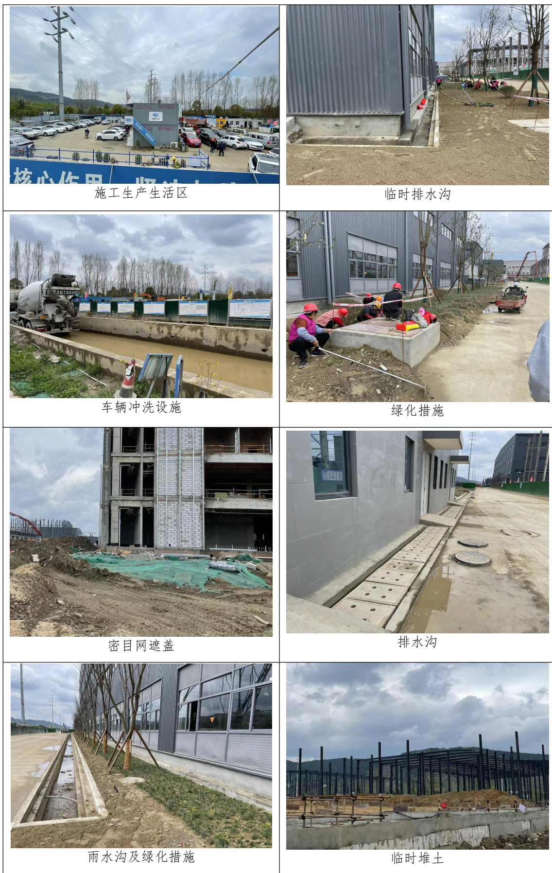
图 2.6-1 项目建设现状图
