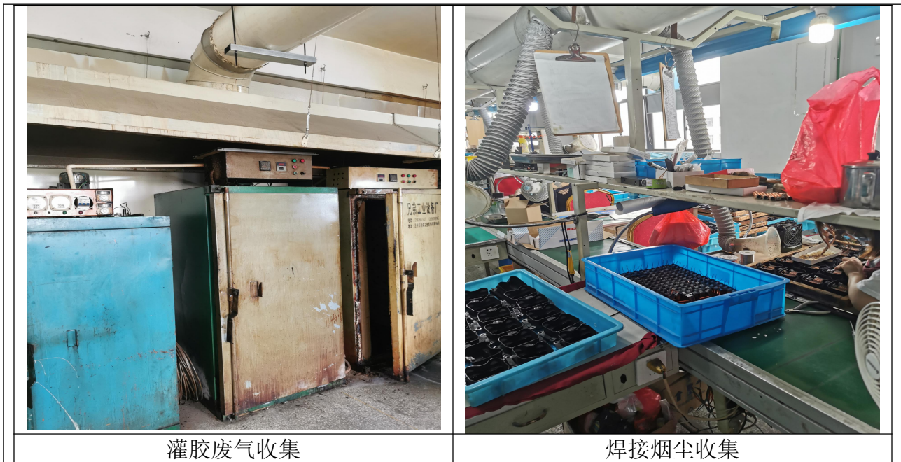
图 3-3 废气处理设施图
