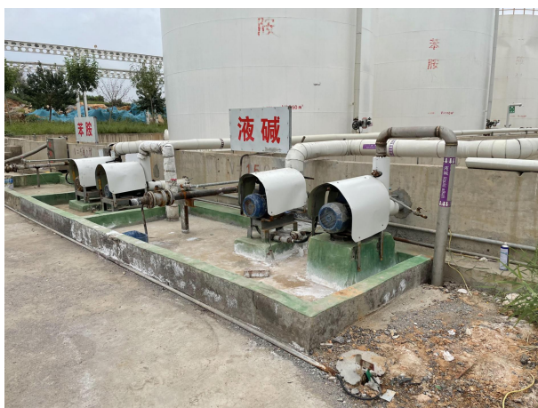
苯胺、液碱装卸区
