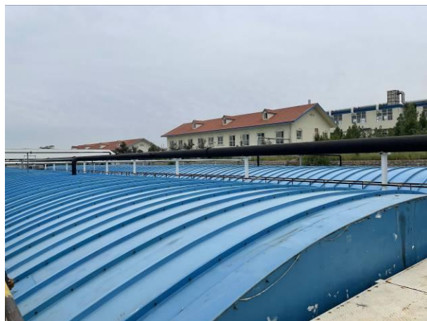
污水预处理区事故池
