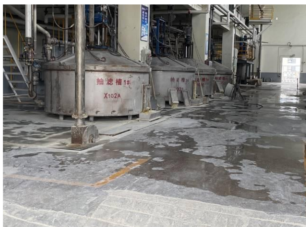
车间内导流槽封闭
