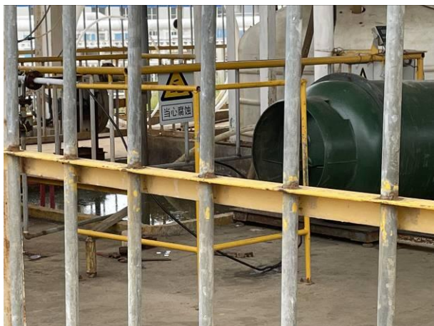
通氯棚事故水池
