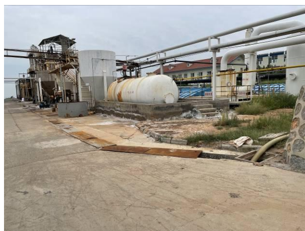
废水导流槽加盖
