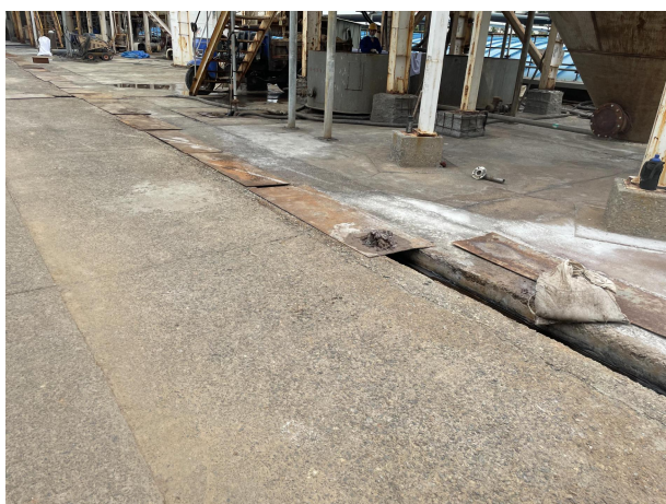
厂区内废水导流槽加盖
