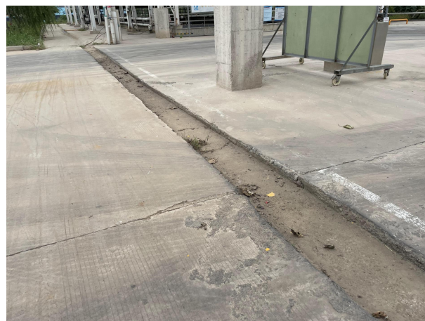
装卸区配套导流槽
