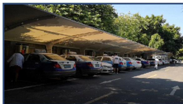
厦门XX(西柯)充电站 160KW双枪直流桩 10台, 合计总功率1600KW
