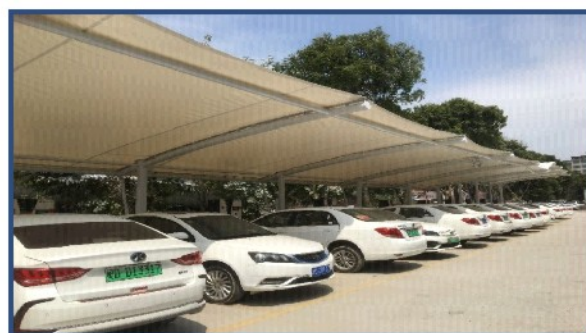
厦门XX(西柯)充电站 160KW双枪直流桩 10台, 合计总功率1600KW
