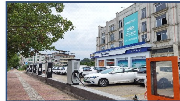
龙岩XXX充电站 120KW双枪直流桩+120KW双枪直流桩 14KW多媒体双枪广告桩 11台,合计总功率990KW
