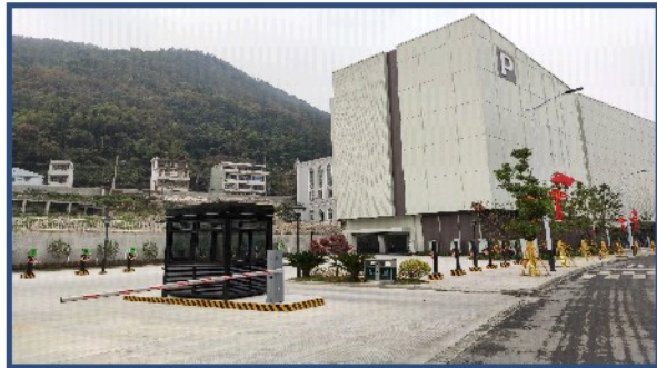
平阳XXX停车楼充电站 60KW双枪直流桩+7KW单枪交流桩 28台,合计总功率938KW
