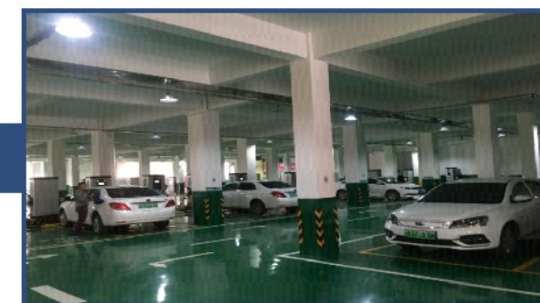
厦门XX(尚忠)充电站 80KW双枪直流桩+120KW双枪直流桩 46台, 合计总功率5400KW
