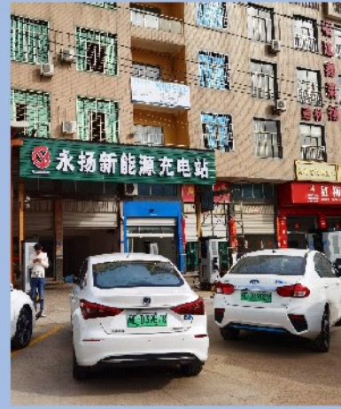
漳州永扬充电站 120KW/200KW双枪直流桩 6台,合计总功率800KW
