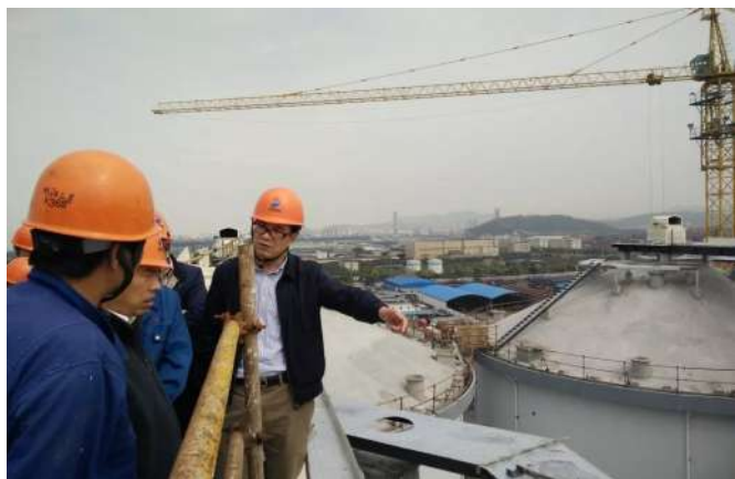
傅安民登上30多米高浅圆仓顶查看工程进展
