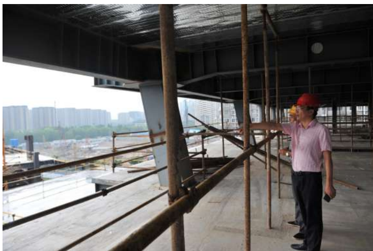
△钱国胜实地查看项目施工情况
